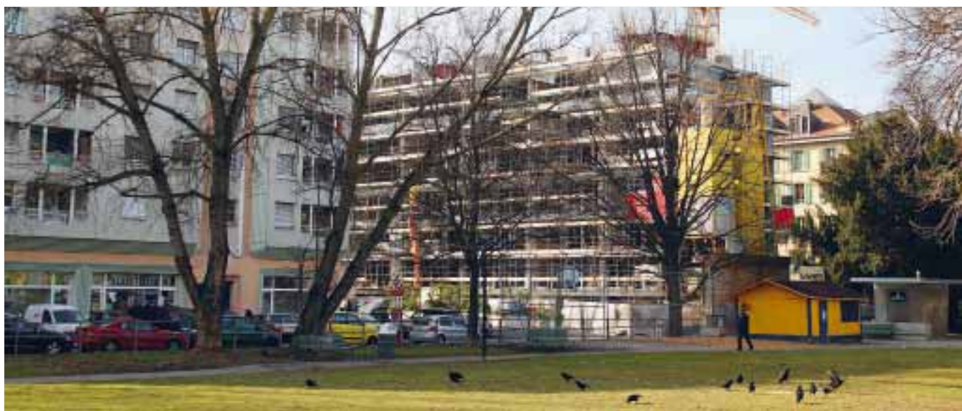
Chantier de l'EVE des Epinettes
