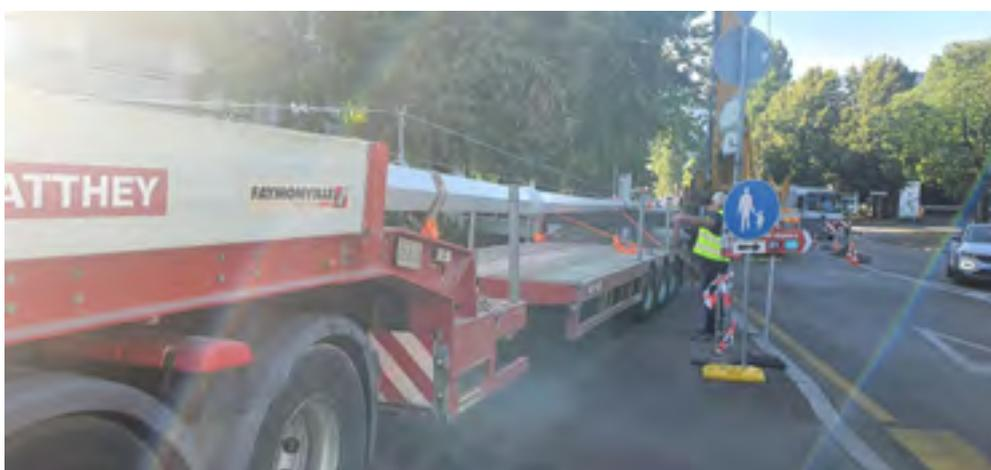
En mai 2021, le projet a reçu un financement de la part du Conseil municipal, par le biais d'une délibération. La rénovation et la mise en conformité des mâts ont été effectuées en juillet 2022. Les mâts ont été démontés à l'aide d'un camion-grue, transportés jusqu'à l'usine pour réparation (traitement de surface, peinture et remplacement des systèmes de hissage) via un convoi spécial.
