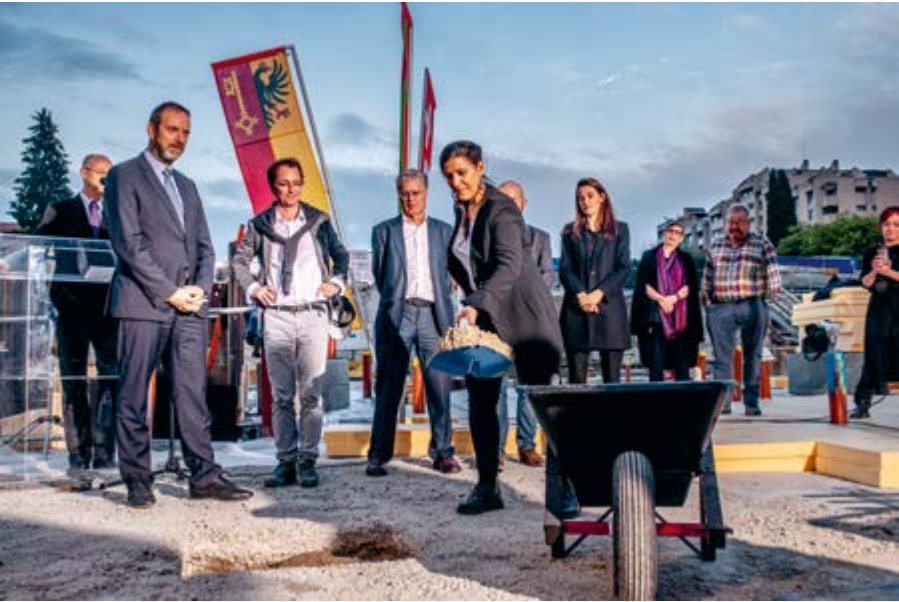
La magistrate ne pouvait manquer le premier coup de pelle du chantier du Théâtre de Carouge en 2018, projet qu’elle a suivi, défendu et porté avec énergie et enthousiasme
