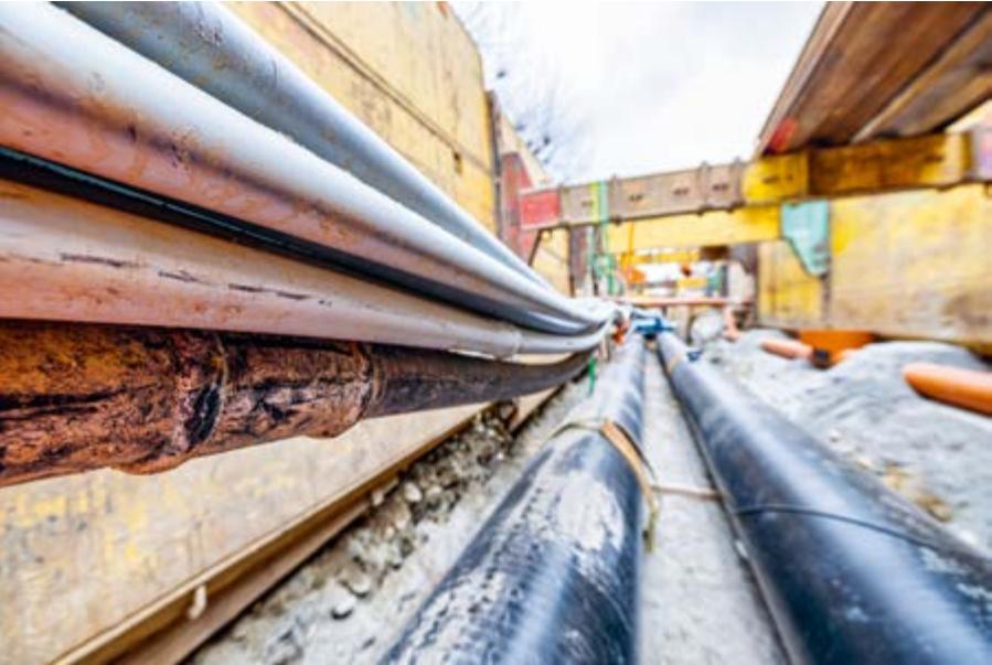
Pose du chauffage à distance, collecteurs d'eau, réfection des rails : différentes interventions sont prévues
