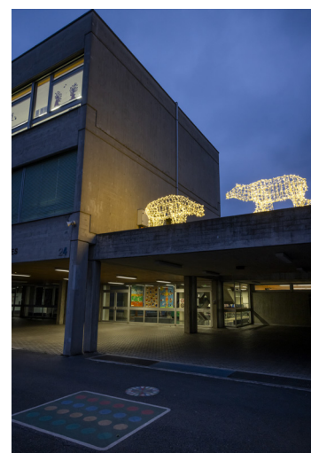
Des ours polaires sur le toit de l'école des Promenades.
