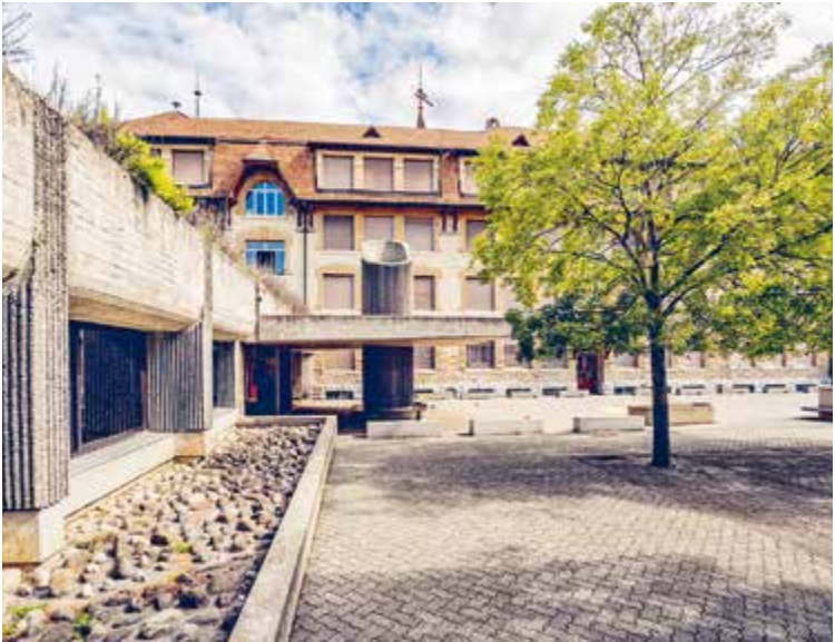
Côté cour, le Centre sportif, ajouté en 1979, sera rénové dans un deuxième temps
