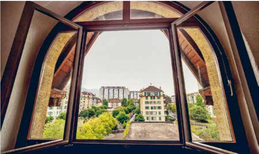
Les nouvelles fenêtres seront en bois, au plus près de celles d’origine de la façade où les cadres existants seront conservés
