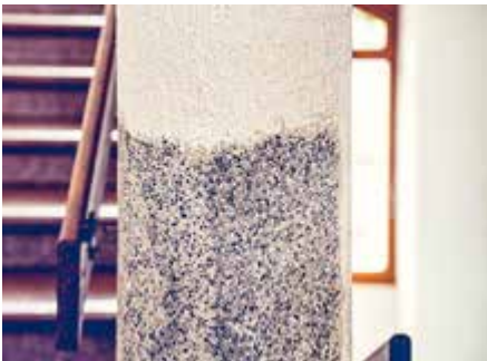
Sous le crépi blanc, on trouve la pesette (gravillon) qui recouvrait les murs à l’origine
