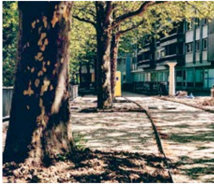
Les travaux de préparation afin d'aménager la séparation des flux: les espaces seront caractérisés par des revêtements de sol différenciés
