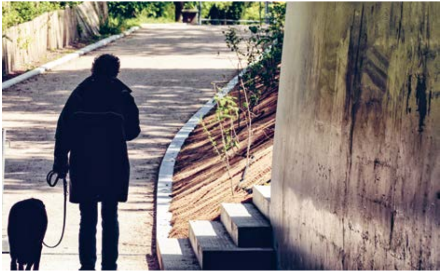
Le tracé évolue sur la rive gauche profitant des passages inférieurs existants comme, ici, celui du pont de la Fontenette qui a été élargi
