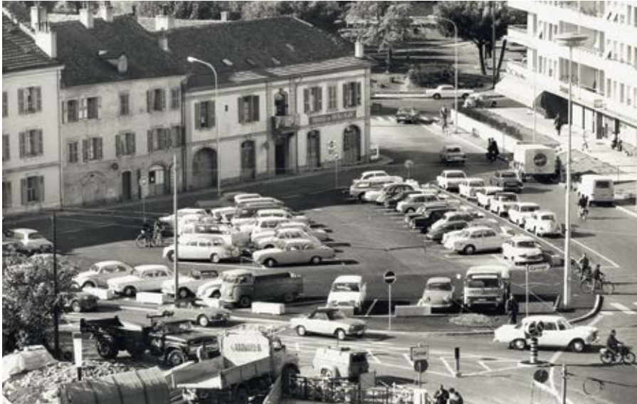
Place de l'Octroi en 1965, un parking à ciel ouvert
