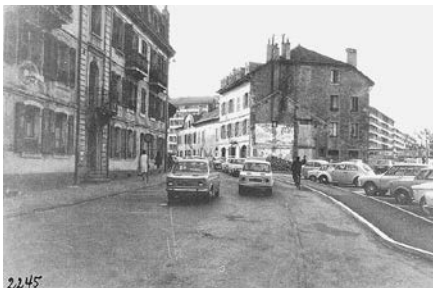
Un tronçon de la rue d'Arve, peu avant 1964, on distingue au loin l'immeuble qui ferme la place de l'Octroi à l'ouest
