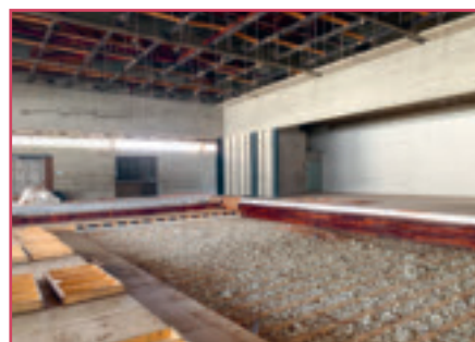
Dans la Salle des fêtes, le parquet a été récupéré et le faux-plafond évacué
