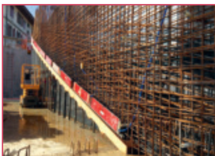
Ferraillage en cours des murs du gradin de la Grande salle
