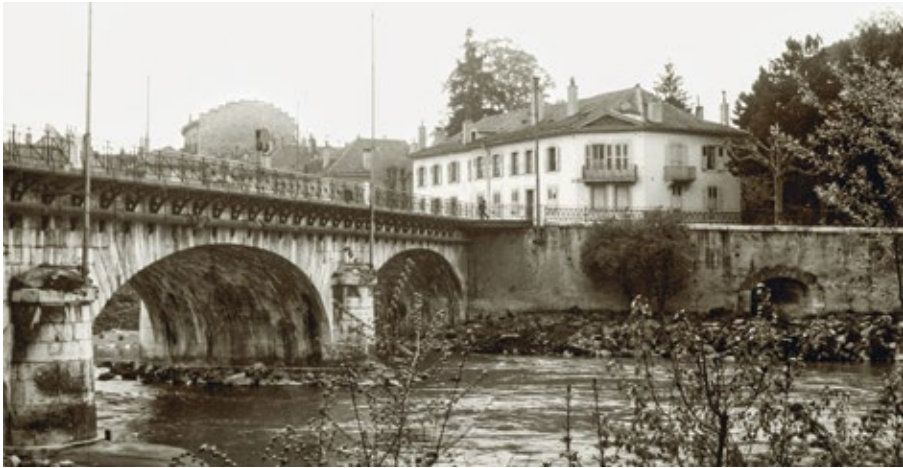
La maison Chaussat (ou la maison Monnard, son nom varie avec le temps) a été démolie vers 1960
