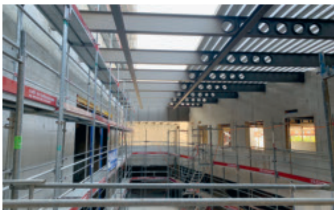
La halle de montage
