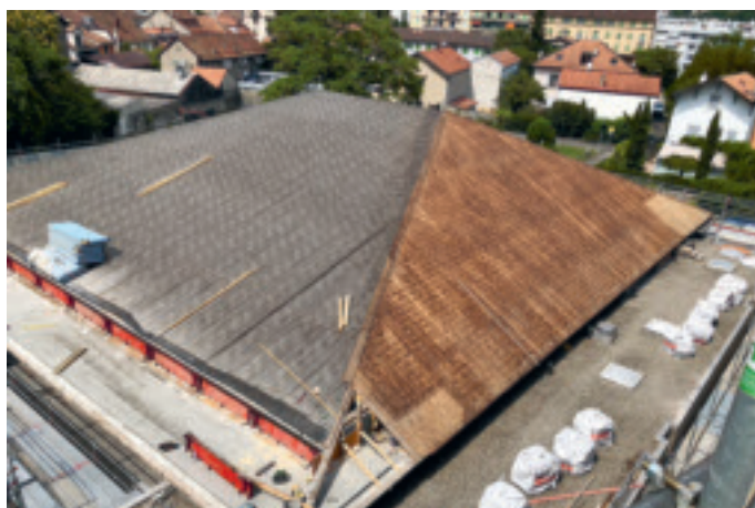
La toiture de la salle des fêtes en réfection
