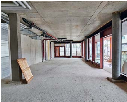
C’est dans ce lieu encore en travaux que prendra place Le félin, café-restaurant communal
