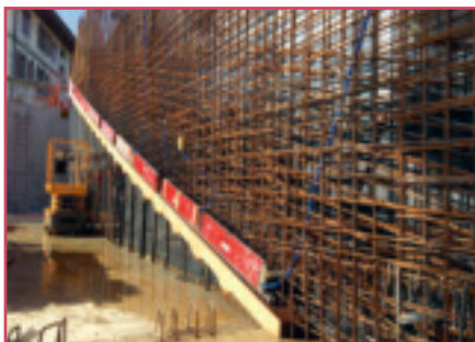
Ferrailage en cours des murs du gradin de la Grande salle
