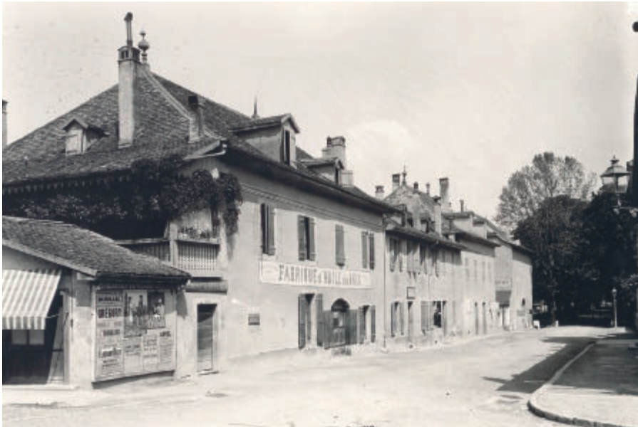
Le Moulin Herpin, vers 1890 (BGE). L'établissement a été transformé à la fin du 19 e siècle en huilerie
