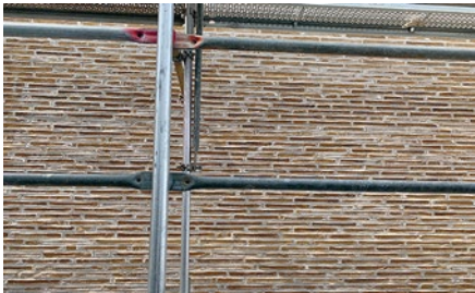
La façade de la petite salle avec des dizaines de milliers de briques à l'ancienne posées avec grand soin, comme en atteste la régularité des rangs et des joints
