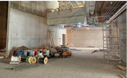
La halle de montage, derrière la scène, avec des kilomètres de câbles électriques pour les courants forts et faibles qui attendent d'être posés dans tout le bâtiment
