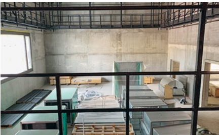
La salle de répétition a la même dimension que la Black-box. Les travaux sont plus avancés, les passerelles techniques sont déjà installées
