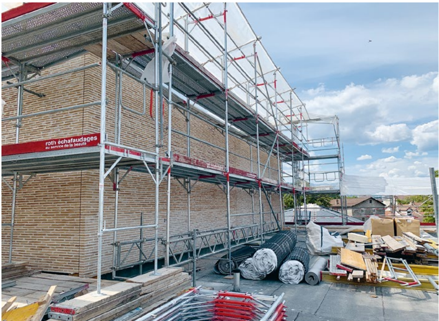
La façade de la petite salle avec des dizaines de milliers de briques à l'ancienne posées avec grand soin, comme en atteste la régularité des rangs et des joints
