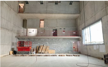
La Black-box, une petite salle destinée à des spectacles contemporains, est hors d'air. Elle est prête à accueillir ses équipements
