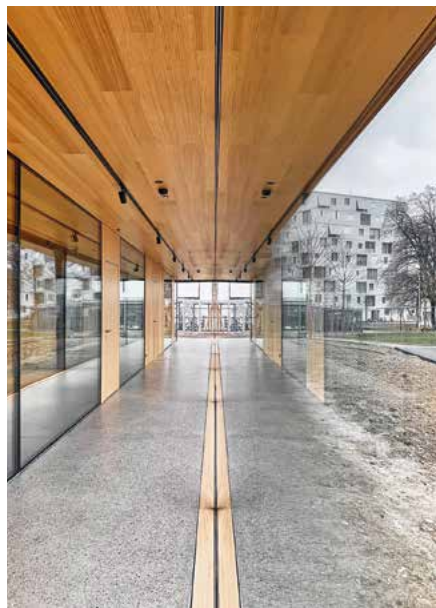
L'Ecole de musique du Val-d'Arve et sa circulation périphérique en double jour avec les salles (à gauche), qui permet une bonne isolation phonique, tout en laissant entrer la lumière
