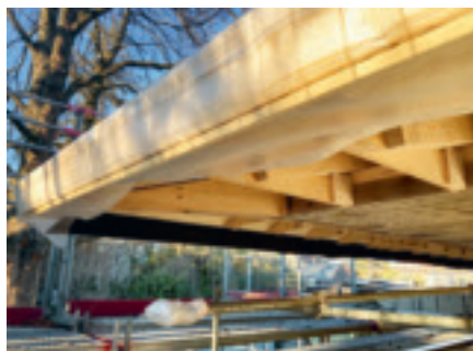
Toiture de la Salle des fêtes
