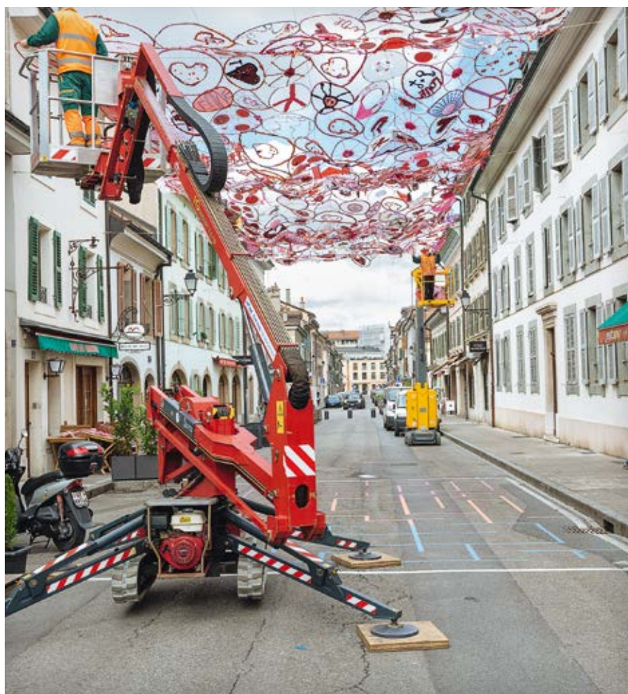
Montage du plafond décoratif de la zone piétonne
