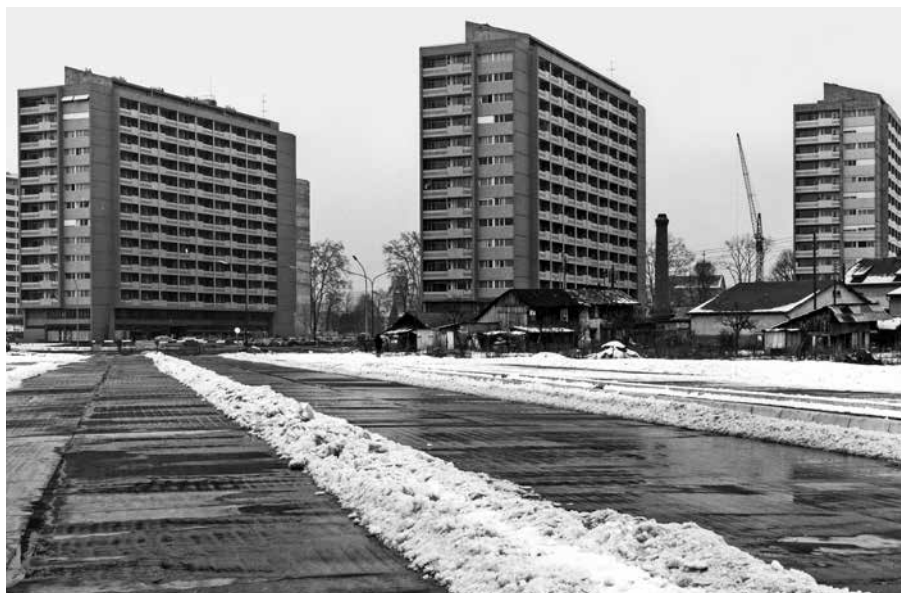
Les Tours de Carouge vues depuis l'avenue Vibert en construction. On distingue encore des petites maisons pas encore démolies
