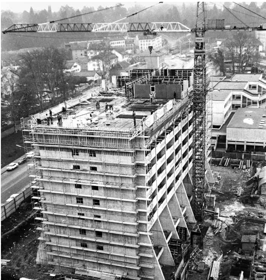
— La 6 e tour en construction; à l'arrière-plan, on aperçoit l'Ecole des Promenades et, plus loin, le Rondeau
