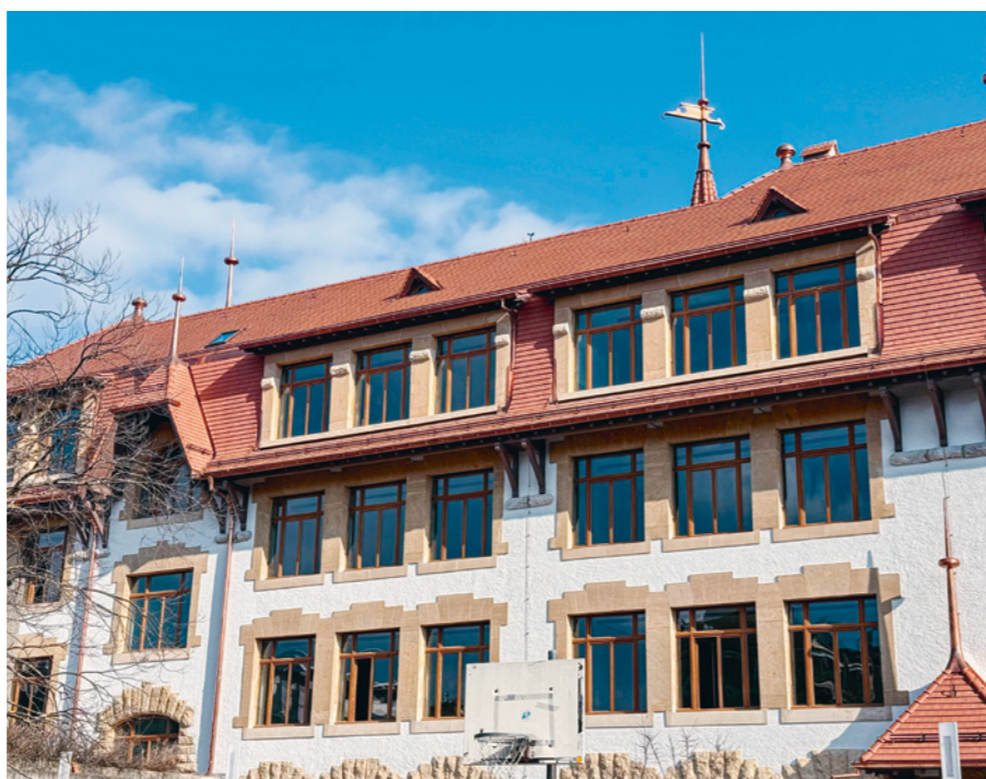
La rénovation a visé la valorisation patrimoniale de ce bâtiment érigé au début du XX e siècle
